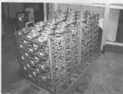
图 2 齿轮低压渗碳
